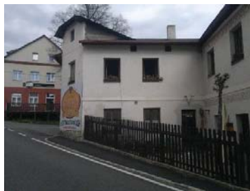
Obr. 39 Dům ve Stašich č. p. 82, přístavek restaurace „U Lva“, nyní hostinec „Štampach“, rodiště Hynka Voldřicha, cirkusového manažera.
